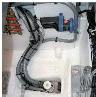
Ausgespart: Lenzbrunnen mit tiefgesetzter Pumpe für trockene Bilge
